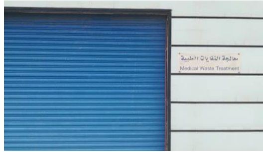
شكل (18): وحدة معالجة النفايات الطبية (متوقفة عن العمل حاليا).
