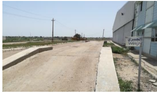
شكل (4): القبان الجسري لوزن النفايات في معمل فرز وإعادة تدوير النفايات في قضاء المحمودية. المصدر (Manager factory, 2018).
